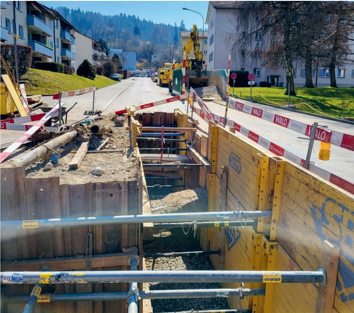
FUCHSENHALDE Erschließung Fuchsenstrasse mit Fernwärme, März 2022.
